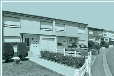
ILLANGE, deux lotissements composés du même modèle de maisons jumelles sont construits en périphérie de la commune, au début des années 1960, l'un à l'Est (rue Robert Schuman en 1963), l'autre à l'Ouest (rues Belle-Vue et Saint-Hubert en 1964)
